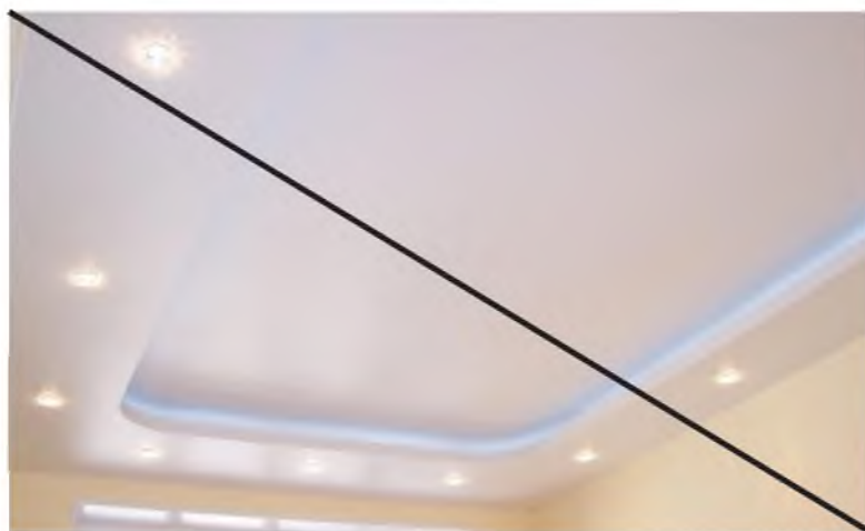
Плохо Многоуровневые гипсокартонные конструкции
