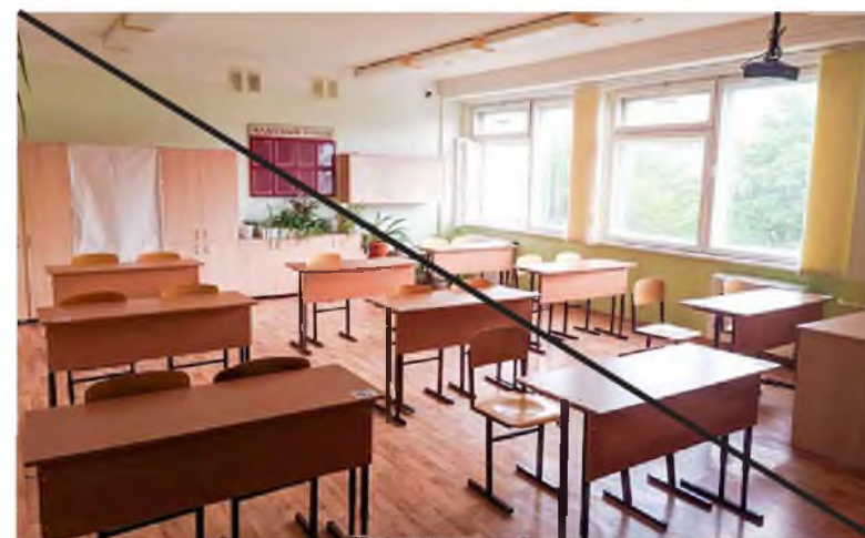
Плохо Линолеум под дерево
